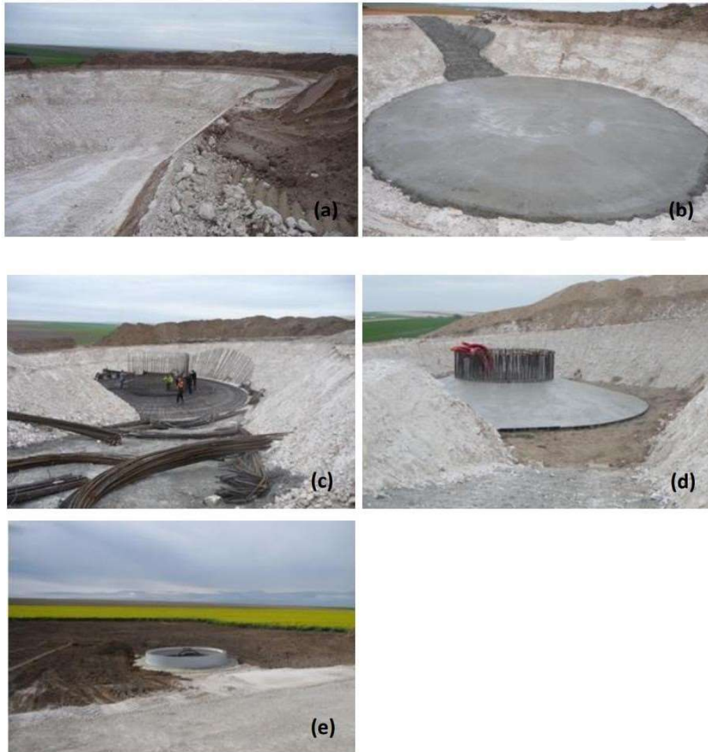
photographie de l'installation des fondations
