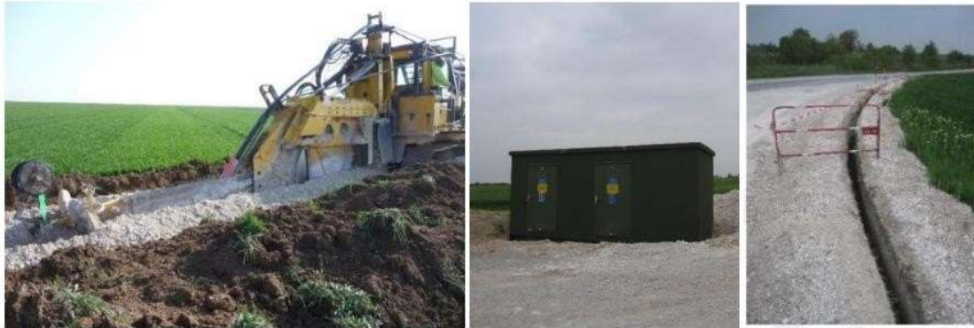
photographie de l'installation du raccordement électrique
