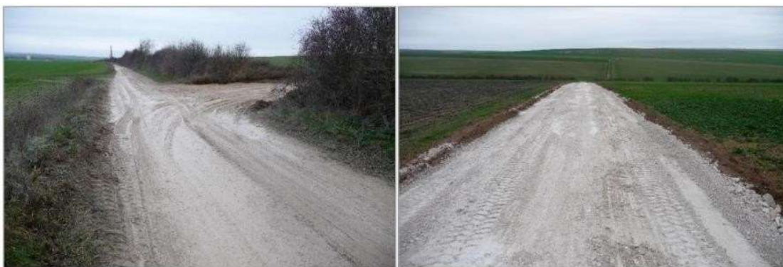
photographies des aménagements et/ou construction de route
