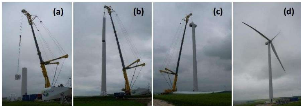
photographie de l'installation des éoliennes
